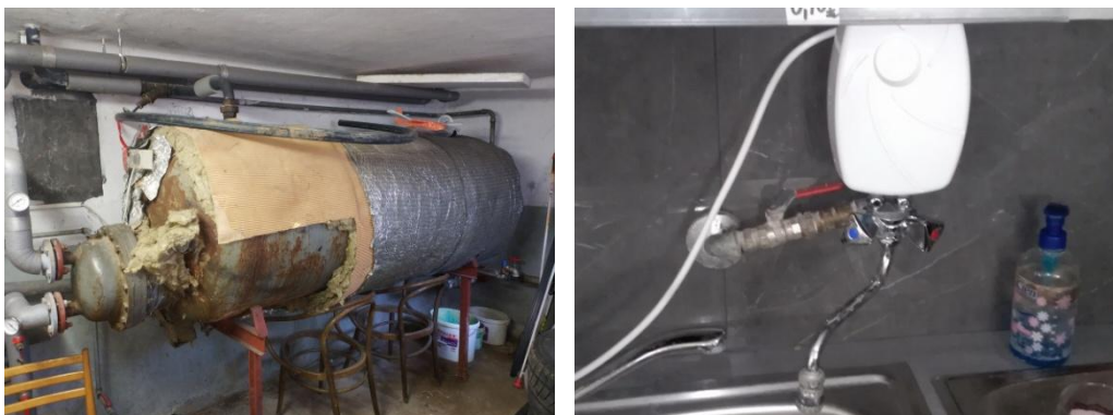
Obrázok 12. Zásobník TV a elektrický prietokový ohrievač
